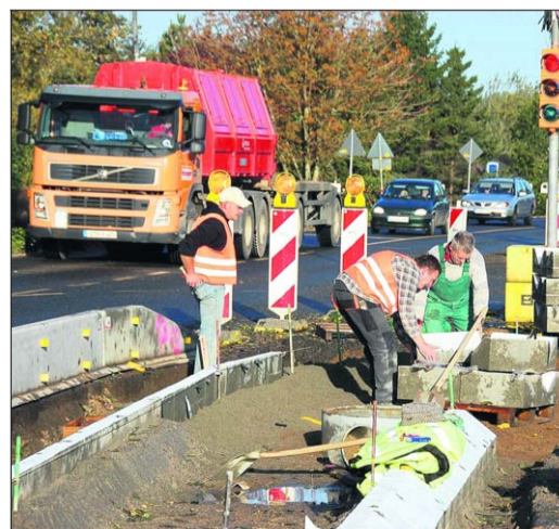
Letzte Arbeiten am Knoten Noorstraße: Anfang November erfolgt die Asphaltierung. Foto Rohde
