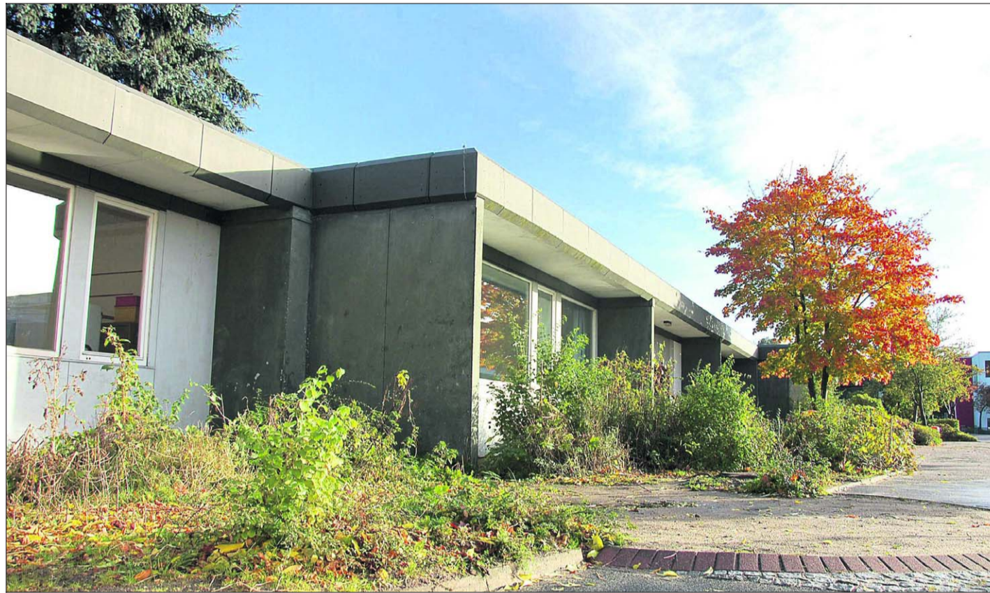
Freigegeben für den Abriss: Die Pavillons am Stifter Schulzentrum sind zur Gesundheitsgefahr geworden.
