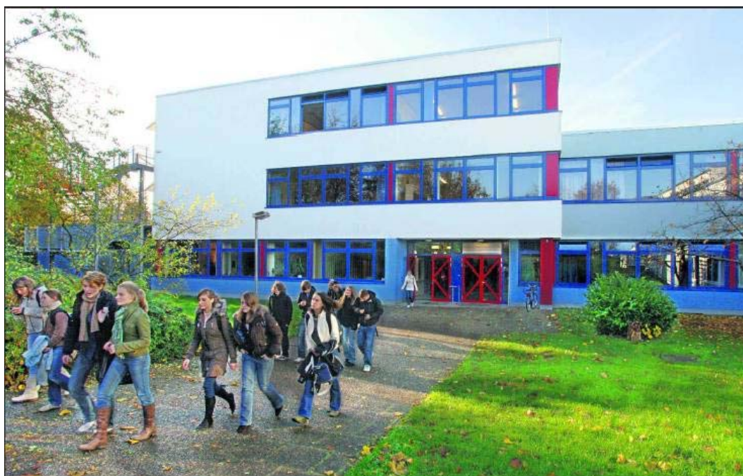
Das Gymnasium Altenholz in neuem Glanz: Fünf Jahre lang dauerten die Sanierungsarbeiten.
